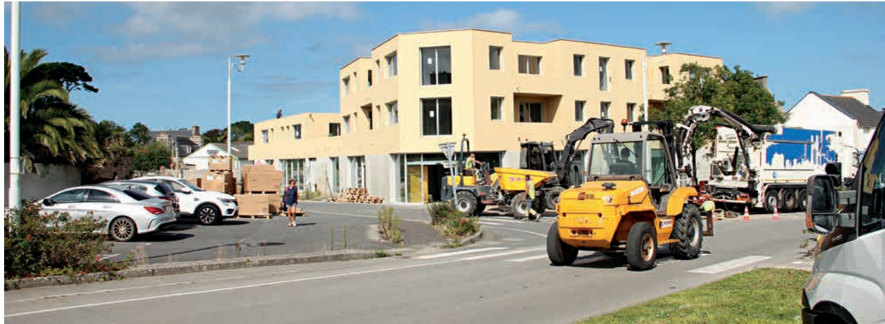
Écoquartier : un projet structurant qui conditionnera l'avenir de la commune jusqu'en 2030
